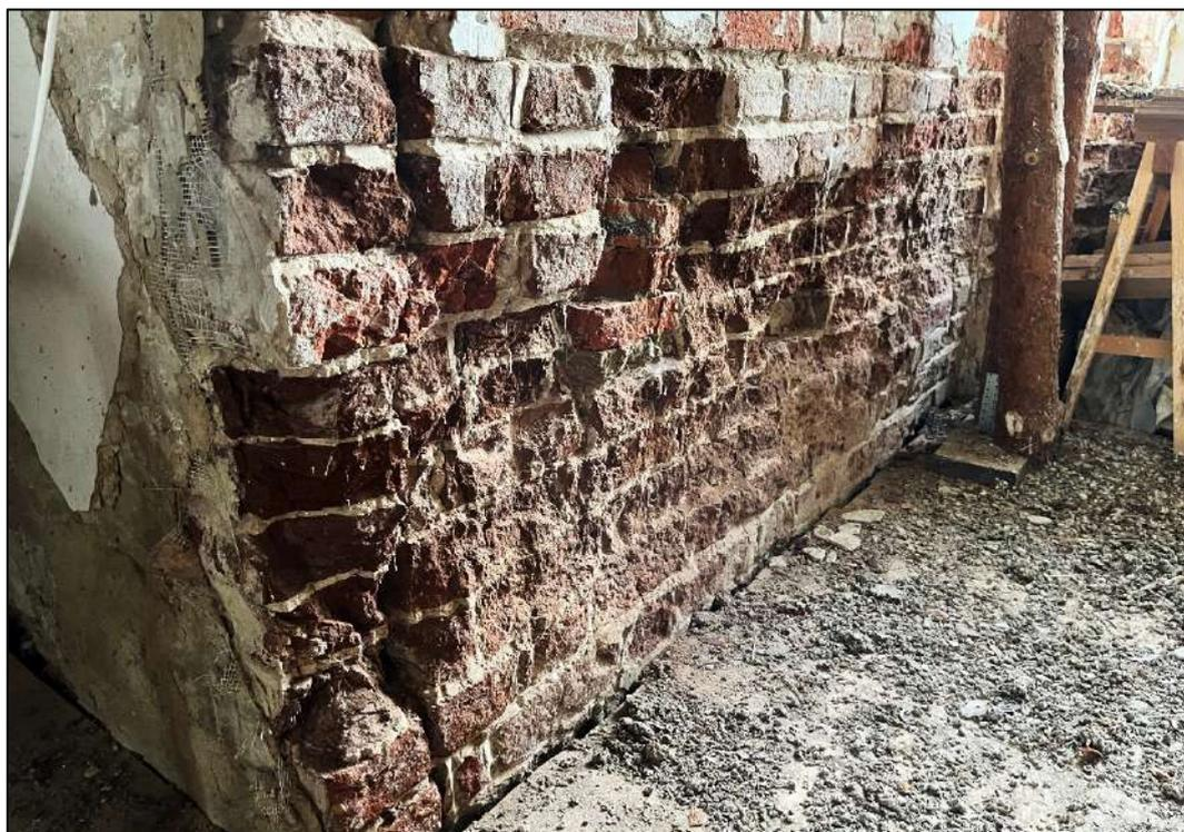
Объект экспертизы. Высолы и следы намокания наружных поверхностей стен, деструкция кладки стен, вызванное негативным воздействием грунтовых вод.
