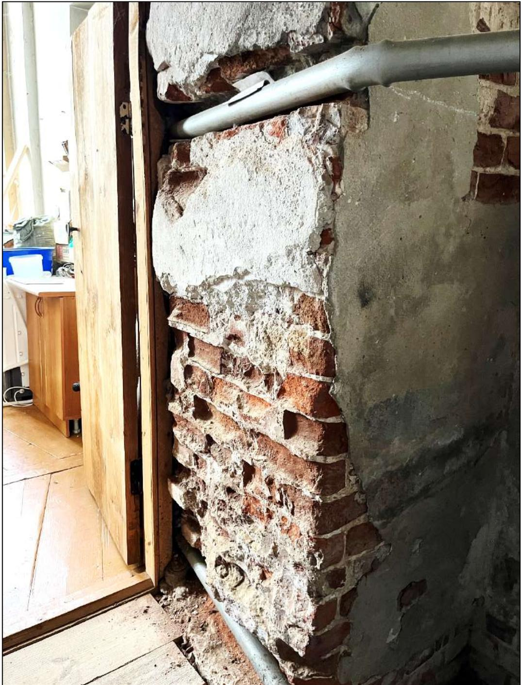
Объект экспертизы. Деструкция кирпичной кладки. Снижение несущей способности конструкций в результате деструкции кирпичной кладки и проведении современных инженерных коммуникаций, высолы.
