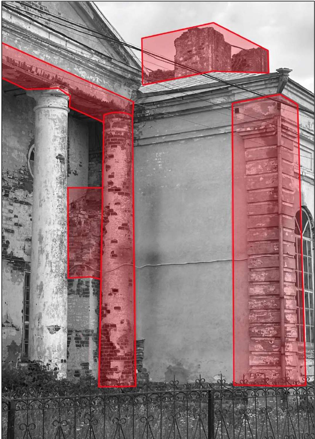
Т.ф. 4. Объект экспертизы. Отсутствие части ярусов колокольни, разрушение кирпичной кладки, осыпание штукатурного слоя, утрата красочного слоя. Деформация несущих конструкций и снижение несущей способности колонн в результате деструкции кирпичной кладки, обвал кирпичных конструкций в критически важных конструкциях. Отсутствие нормативной отмостки и системы водоотведения
