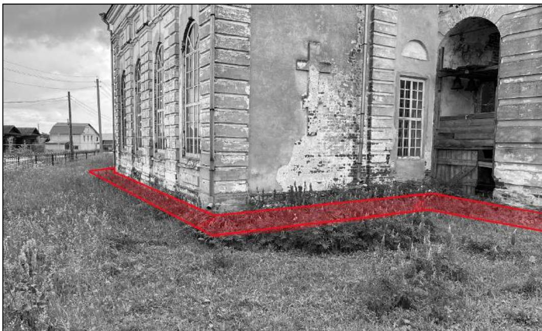
Т.ф. 1. Объект экспертизы. Отсутствие нормативной отмостки и системы водоотведения.
