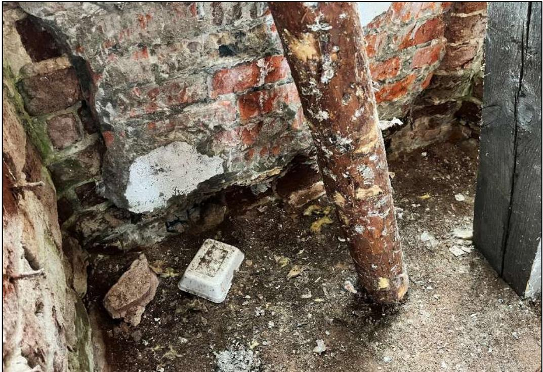
Объект экспертизы. Высолы и следы намокания наружных поверхностей стен, деструкция кладки стен, вызванное негативным воздействием грунтовых вод.
