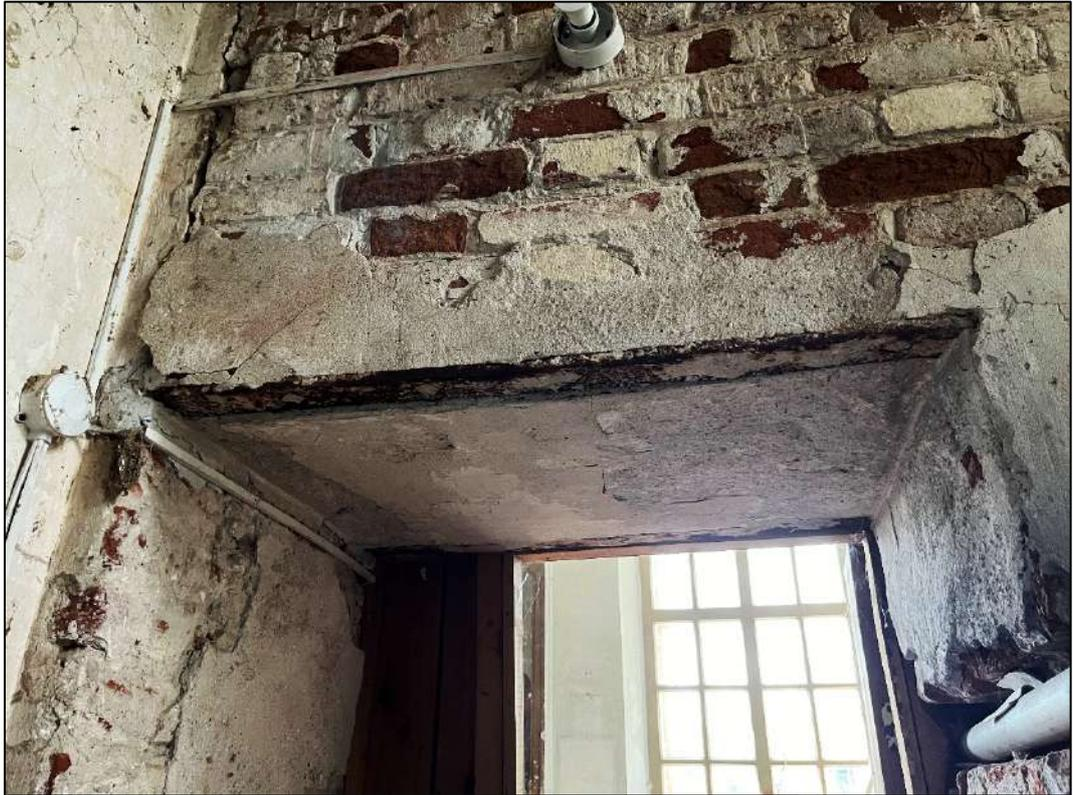
Объект экспертизы. Коррозия поздних металлических перемычек, высолы.
