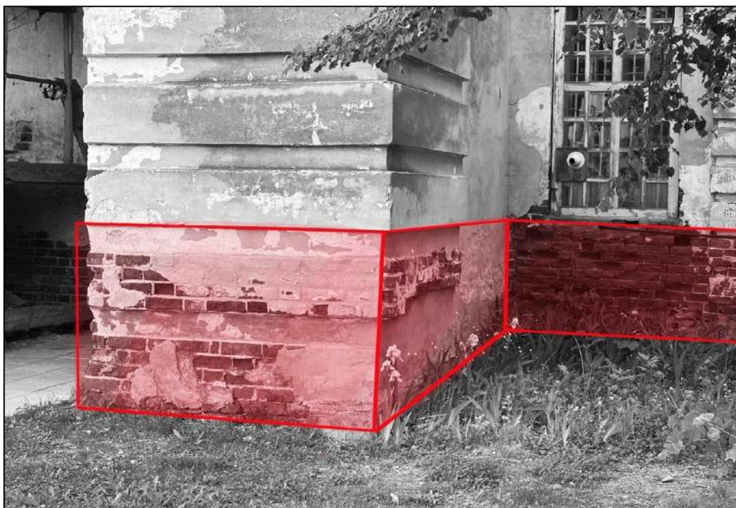
Т.ф. 6. Объект экспертизы. Высолы и следы намочания наружных поверхностей стен, деструкция кладки стен, вызванное негативным воздействием грунтовых вод, снижение несущей способности конструкций в результате деструкции кирпичной кладки, современная главка.
