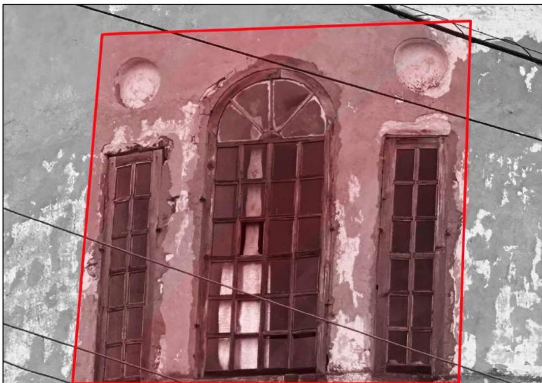
Т.ф. 4. Объект экспертизы. Отслоение штукатурного слоя, осыпание красочного слоя, поражение гнилью столярного заполнения оконных проемов.
