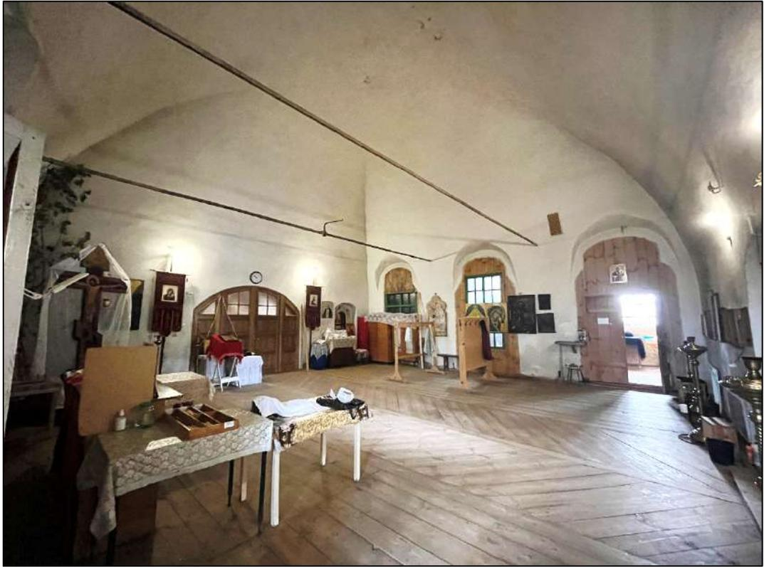
Объект экспертизы. Кирпичный объем исторической части объекта. Сводчатая система перекрытий с распалубками, воздушные связи, «обновленное» покрытие пола.
