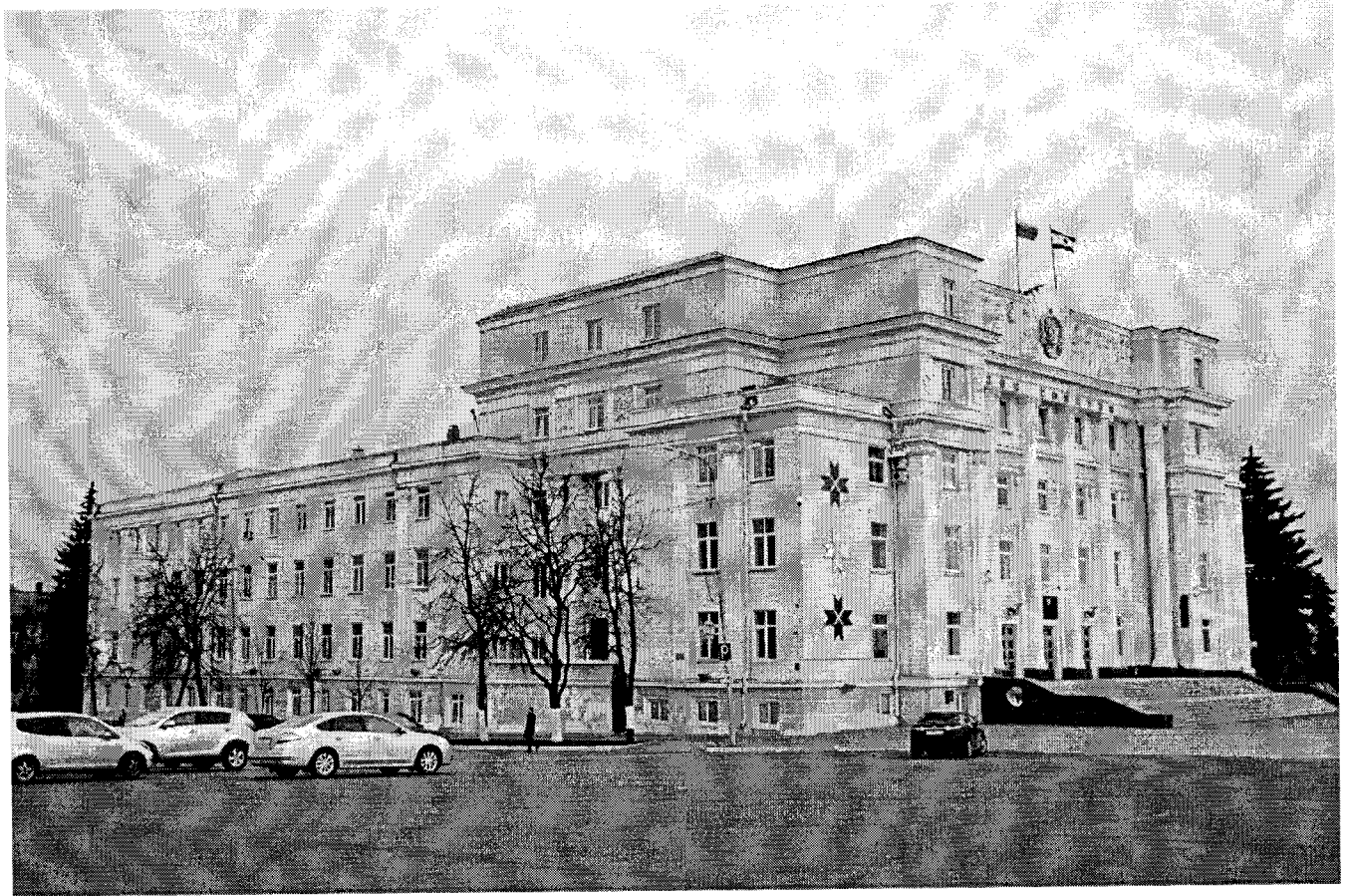
Фото 5. Общий вид здания
